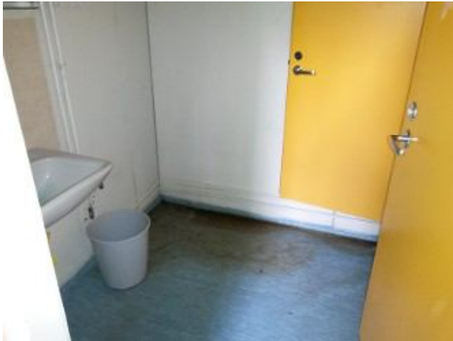
Tyttöjen wc. Lattialla vettä
